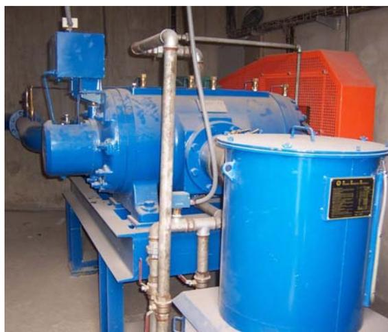
Compresor eléctrico que ha substituido a los antiguos compresores de gasoil
